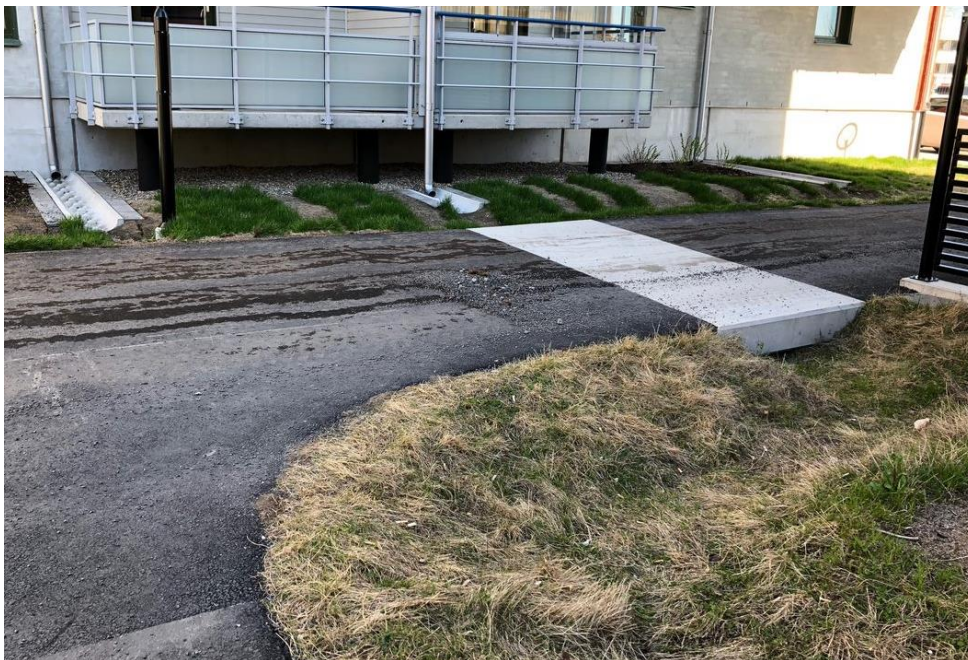
Figur 11. Utkastare med lökränna till svackdike inom kvarter för trögavledning av dagvatten, betongbro för cykelöverfart Bildkälla: WSP Umeå
