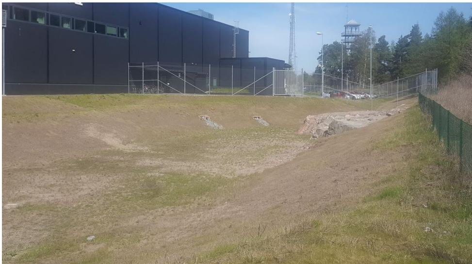
Figur 13. Torrdamm i Uppsala för fördröjning och rening Bildkälla: WSP Uppsala
