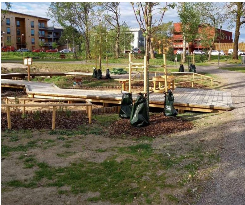
Figur 14. Torrdamm i Norrköping för fördröjning och rening som nyttjas som lekpark och vistelseyta i torrperioder. Bildkälla: WSP Umeå
